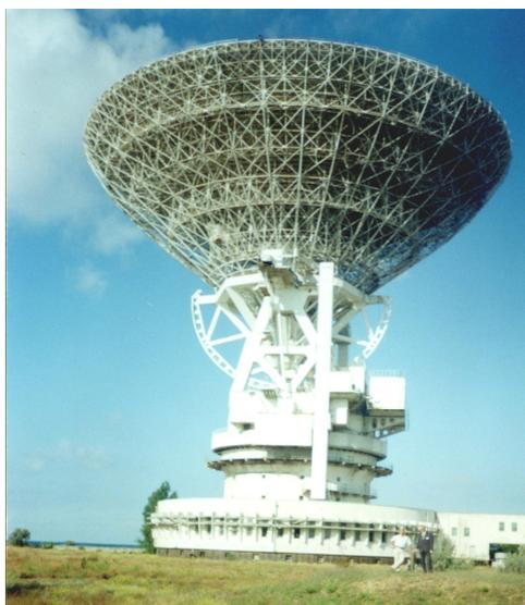
Рис. 4.6. 70-м радиотелескоп Центра космической связи в Евпатории (фото автора)
